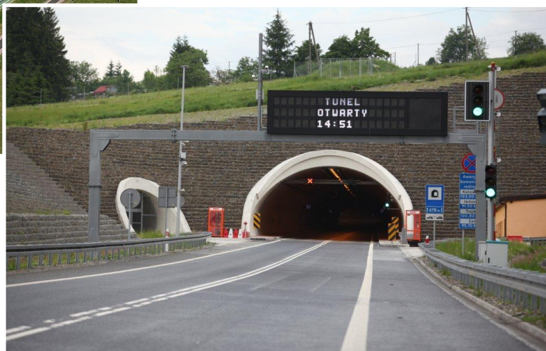
- tunel drogowy „Emilia” pod Sobczakową Grapą w miejscowości Laliki - droga ekspresowa S-69 Żywiec - Zwardoń
