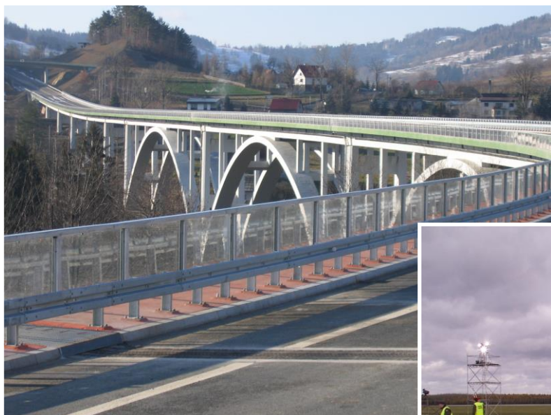
- wiadukt w Milówce na odcinku Milówka - Szare, droga ekspresowa S-69 Żywiec - Zwardoń
