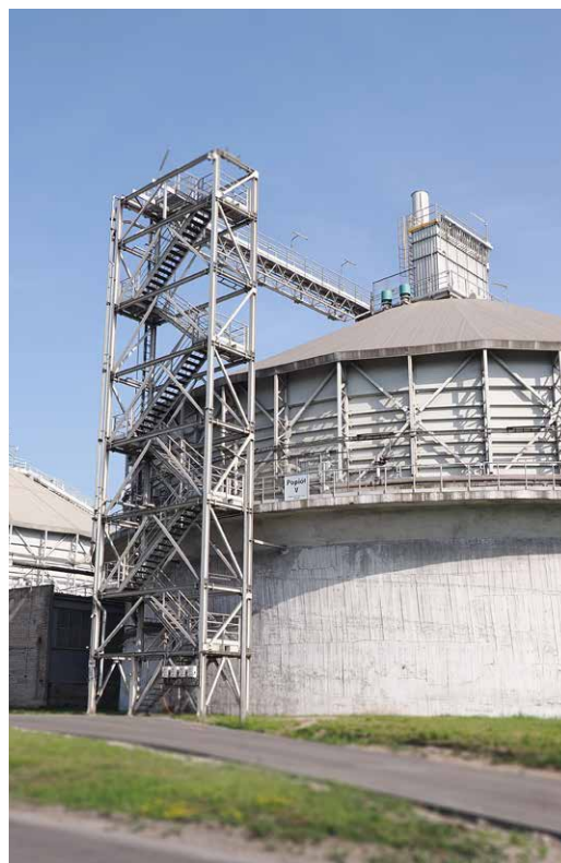
Fot. Błażej Boryń, Zbiornik magazynowy popiołu
