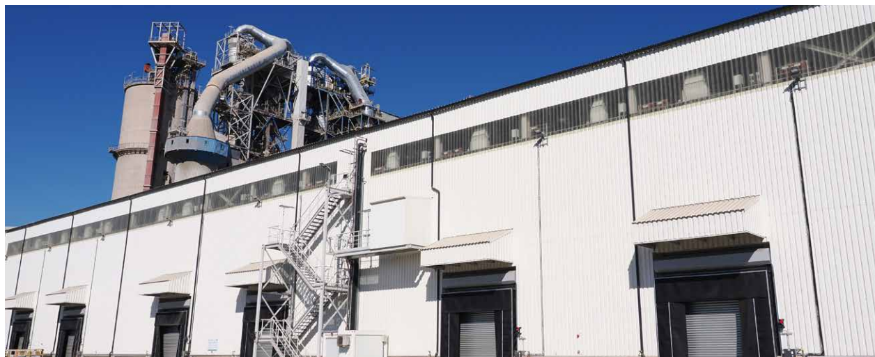
Fot. Błażej Boryń, Hala paliw alternatywnych
